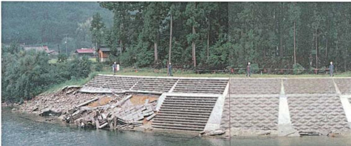
図 3.2 流体力によるブロックの移動・流出による被災事例
