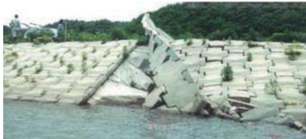
写真 3.1 流体力によるブロックのめくれによる被災事例
