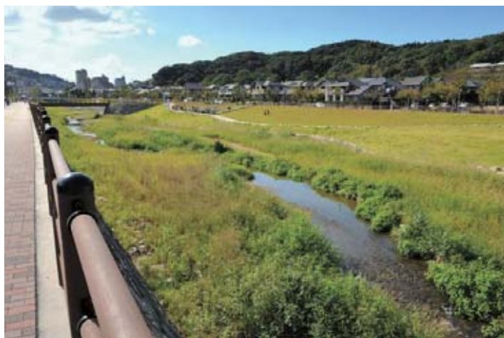
写真 4.1 平常時の流量に見合ったみお筋部の形状と自然な水際部が確保されている例（板櫃川：福岡県）
