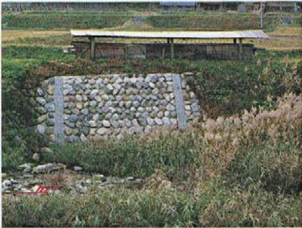
小口止めが浮き上がって見える
