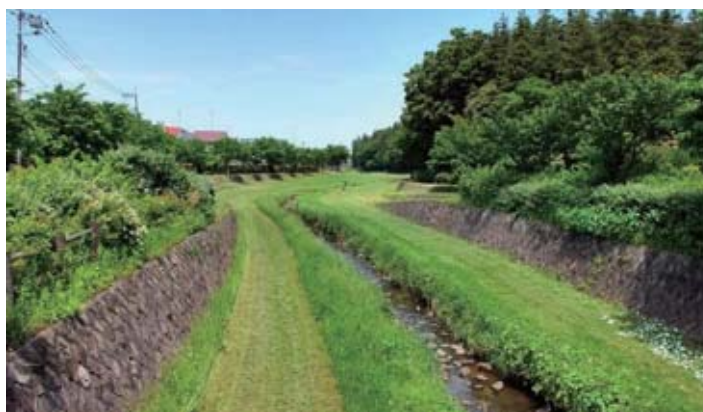
写真 4.26 周辺空間に溶け込んだ自然石護岸 （和泉川：神奈川県）
