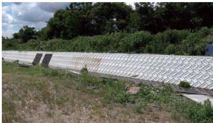
写真 4.25 周辺との明度差が大きい護岸
