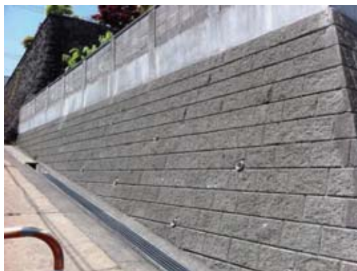
写真 4.52 水抜きパイプを設置した例
