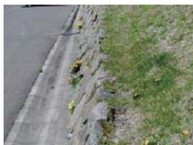
図 4.40 石積み天端処理例
