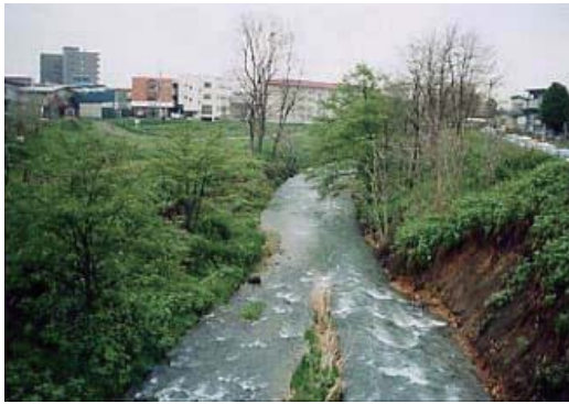
写真 4.2 復旧自然河岸を護岸にすることによる粗度が低下した例
