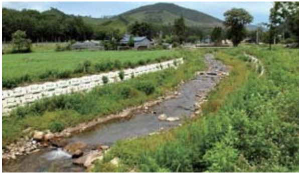
写真 4.23 現地の発生材で寄せ石をして自然な水際を形成している事例 (元町川：岩手県)
