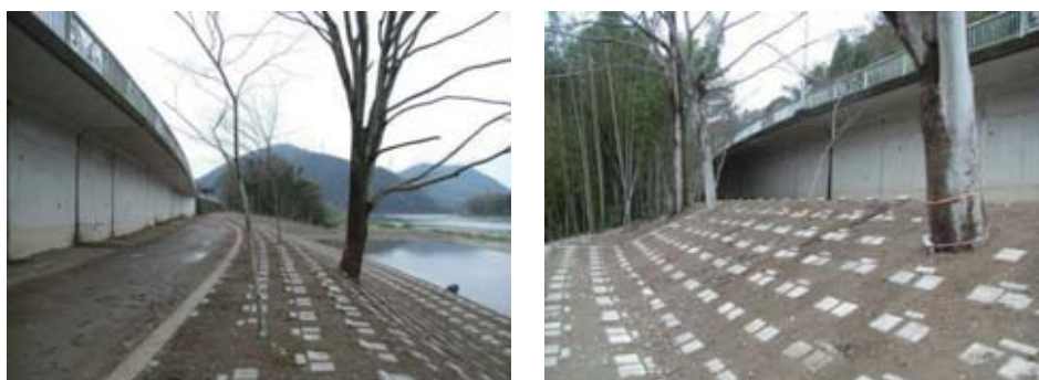
写真 4.20 低水護岸整備にあたり河畔樹木を保全した例（長良川：岐阜県）
