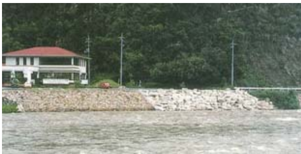
写真4.40 左 素材1個1個が識別できない例 右 素材1個1個が識別できる例
