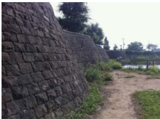
写真 4.52 水抜きパイプを設置した例
