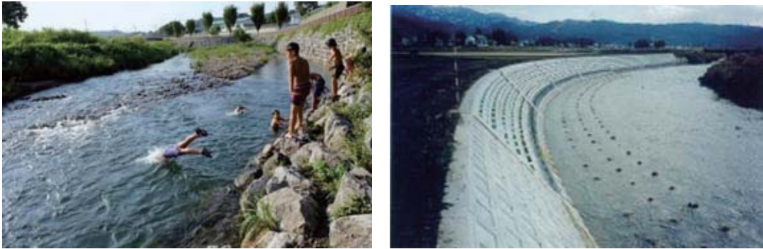
写真 4.18 湾曲部外岸の淵の保全を図った例（左）とそうでない例（右）
