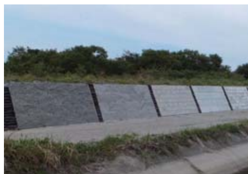
写真 4.33 景観実験護岸
