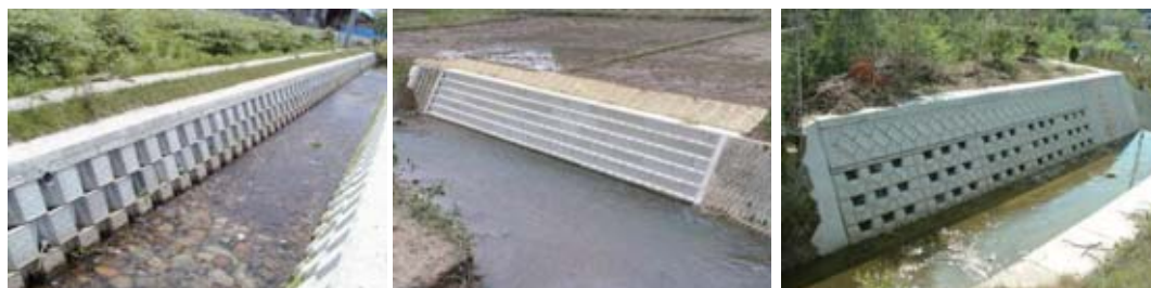
写真 4.35 近年見られるようになった典型的な護岸ブロックの景観パターンの例 千鳥配置のパターン（左）、階段状のパターン（中）、穴が目立つパターン（右）
