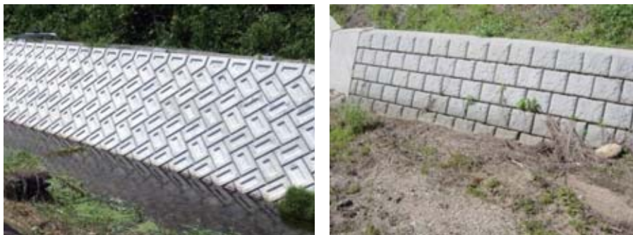
写真 4.34 谷積み（左）と布積み（右）のパターン
