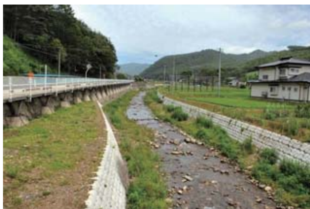
写真 4.46 天端コンクリートを打たずに土で埋め戻した事例（元町川：岩手県）
