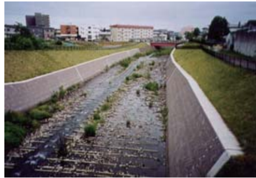
写真 4.2 復旧自然河岸を護岸にすることによる粗度が低下した例
