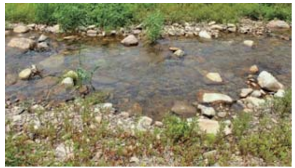
写真 4.23 現地の発生材で寄せ石をして自然な水際を形成している事例 (元町川：岩手県)
