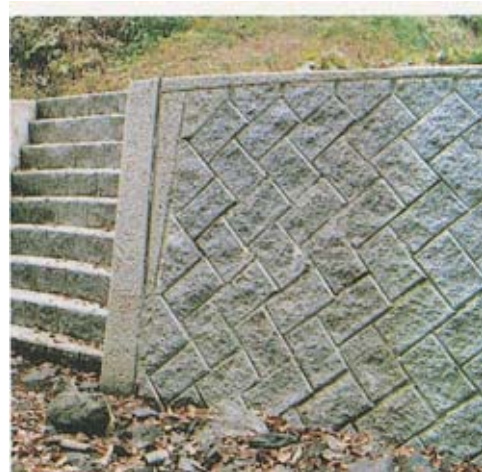
半割ブロックの小口止めの表面処理
