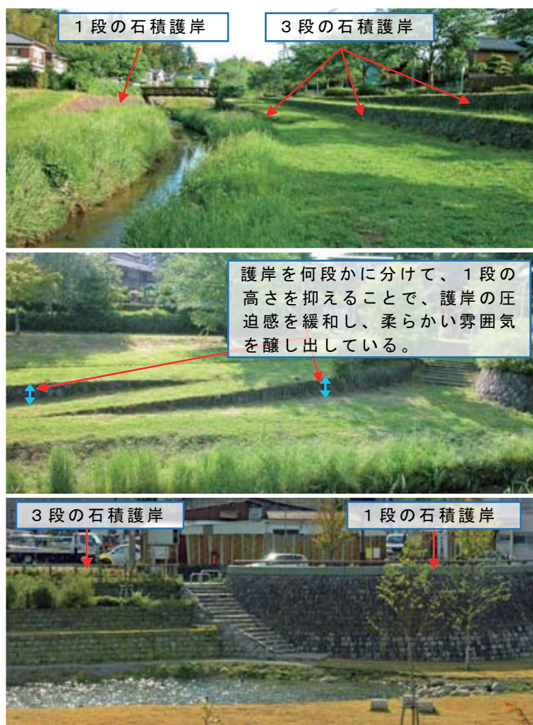
写真 4.21 護岸に小段をつけ、護岸の圧迫感を緩和した例（和泉川：神奈川県）
