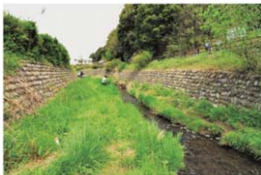
図 4.22 水際部を再生した例
