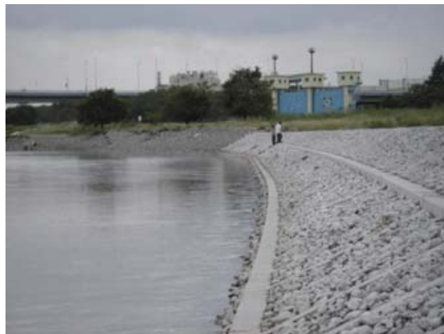
写真 4.28 明度の高い低水護岸の例
