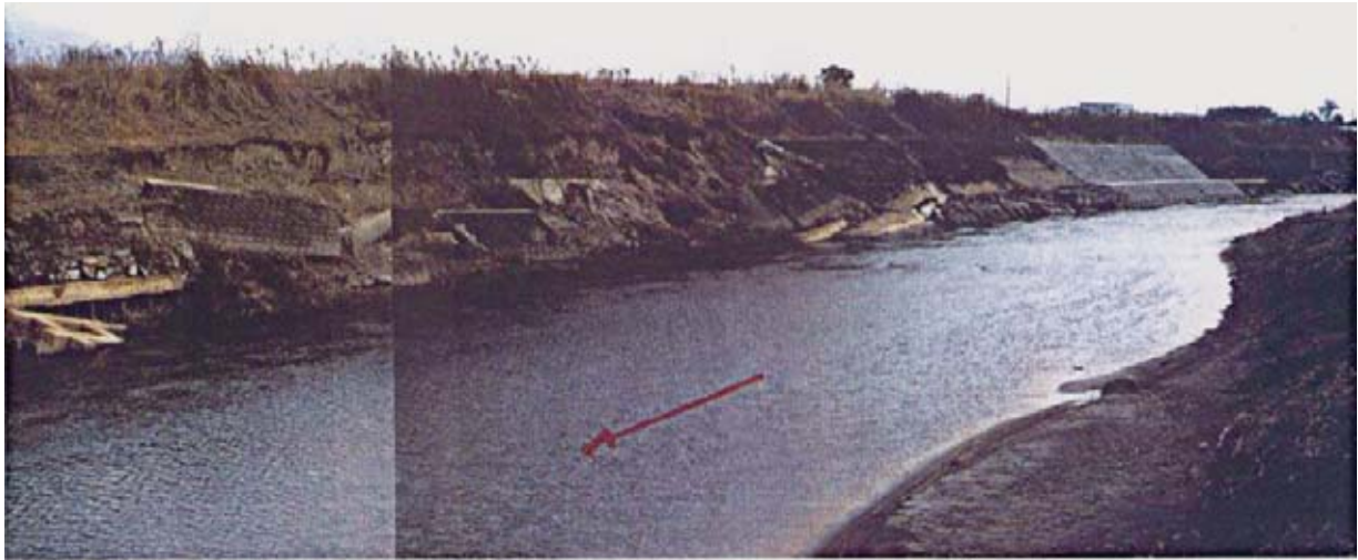
写真5.2 被災状況 コンクリートブロック護岸が被災
