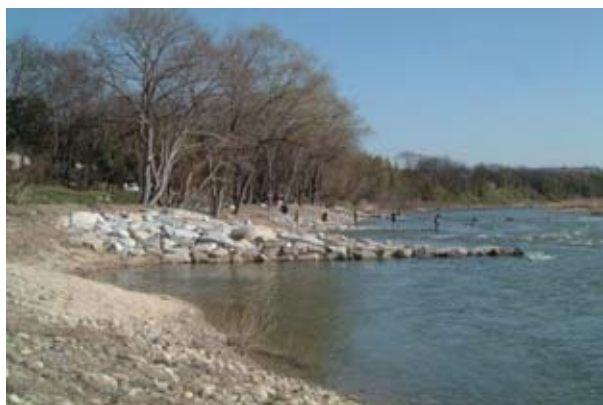
写真 5.1 低水河岸に水制工を設置した事例（矢作川：愛知県）
