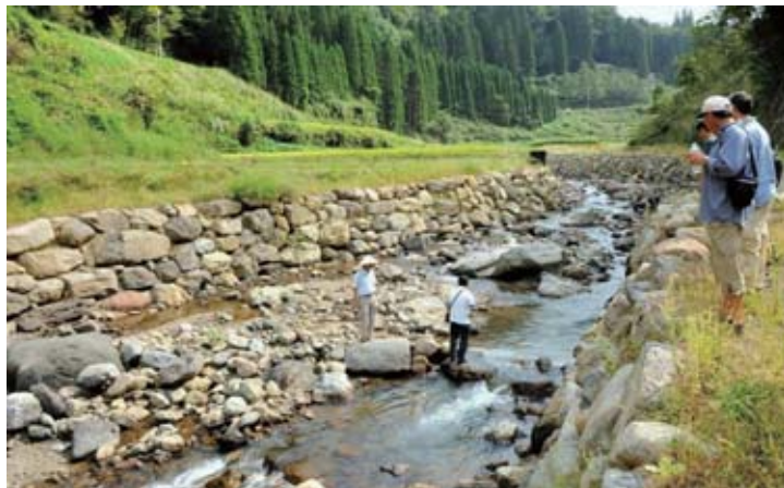
写真 6.3 被災後に河床に見られた巨礫を床止めとして保全した事例（山附川：宮崎県）
