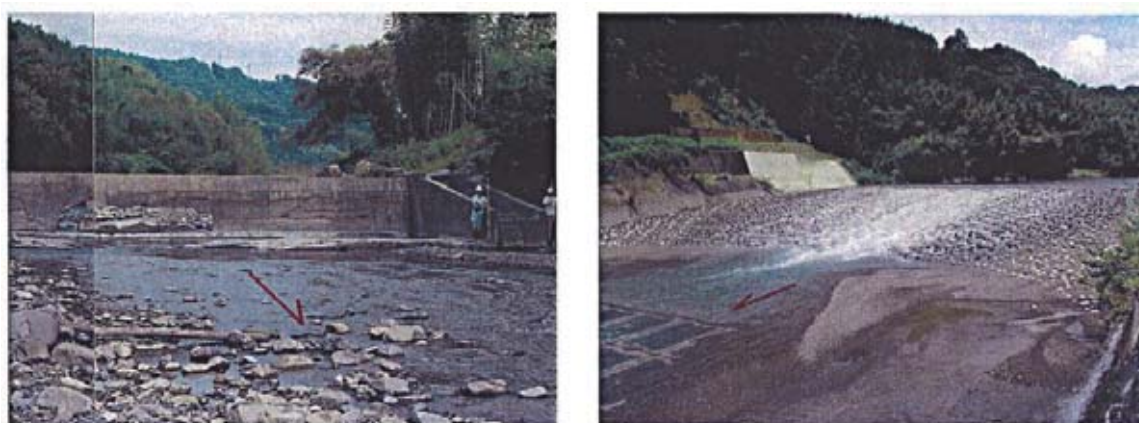
写真 6.2 落差工が被災したため粗石付斜曲式の落差工で復旧した事例
