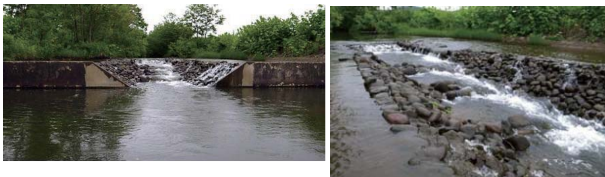
写真 6.1 下流区間の河床低下に対して落差工の一部を切り欠いて早瀬構造とし
