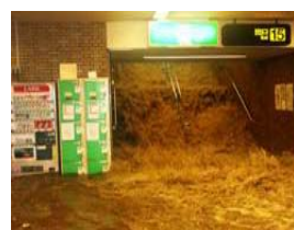
地下街のはん濫状況 福岡市
