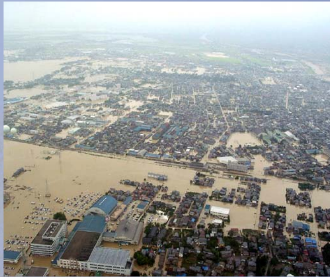
五十嵐側の破堤による浸水 新潟県三条市
