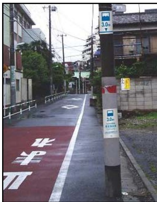
電柱への添加式表示 (実績浸水深)
