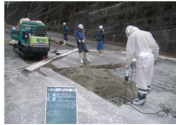
コンクリート打替え
