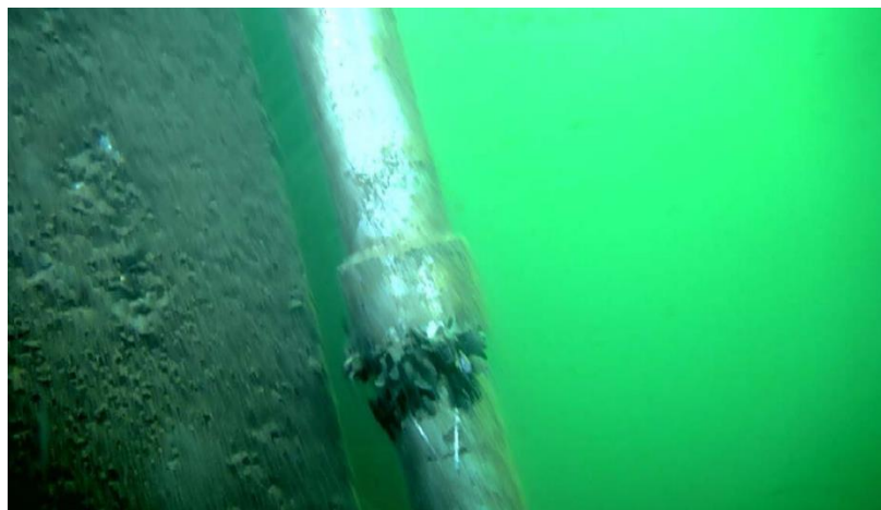
写真 4.6.2 部材損傷部の静止画例
