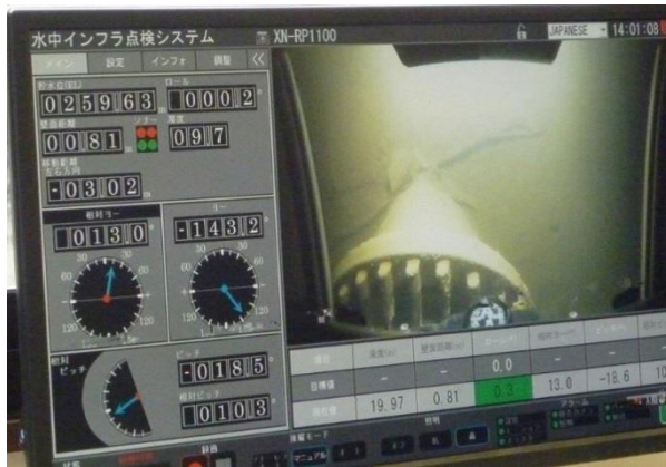
写真 4. 4. 4 概査実施状況（充水管流入口点検状況）
