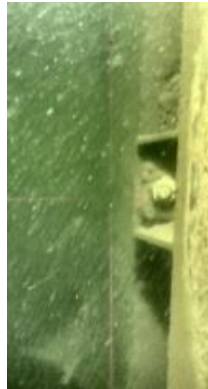
図 4.4.1 戸当りレール固定金物精査状況
