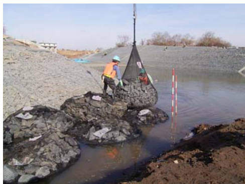
左写真： 袋型根固め用袋材
