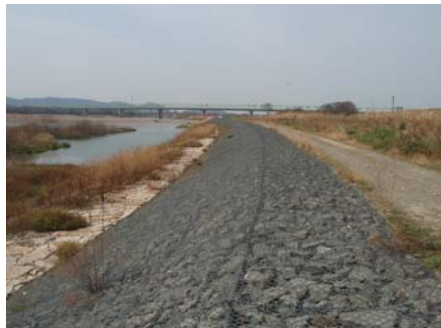
左写真： 鉄線籠型護岸
