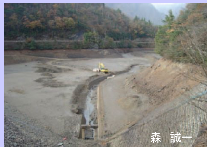
水抜きされた伊自良湖
