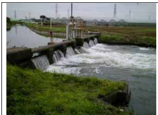
写真-3.3 用水路・排水路内の堰の例
