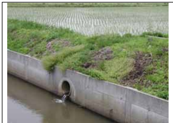
写真-3.2 水田と排水路の落差の例
