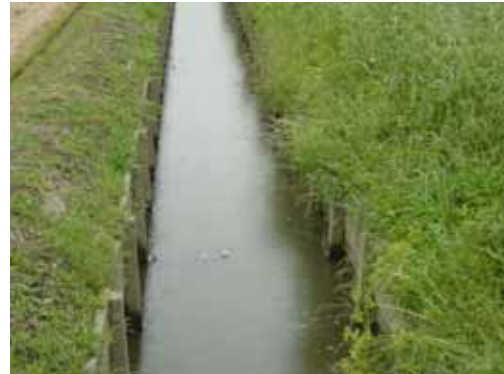
写真-3.7 B3 コンクリート三面張り
