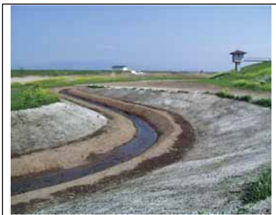
写真-4.3(1) せせらぎ式魚道・菊池川
