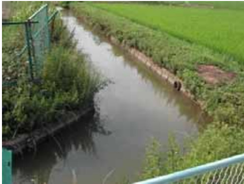
写真-3.6 B1～B2 コンクリート三面張り
