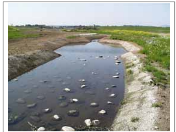
写真-4.3(2) せせらぎ式魚道・菊池川
