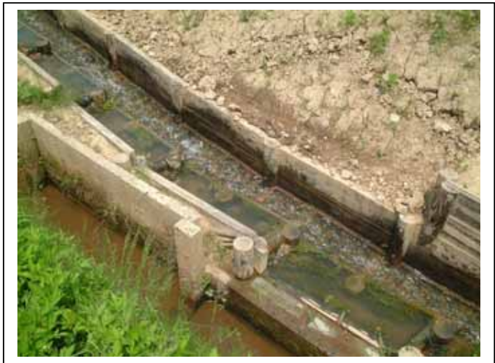
写真-4.4(2) 水田魚道内の流況・鎌谷川
