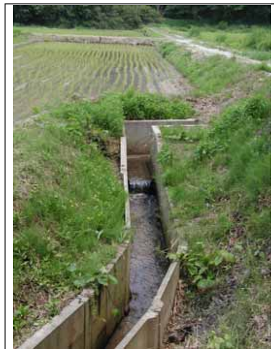
写真-3.4 コンクリート化された水路
