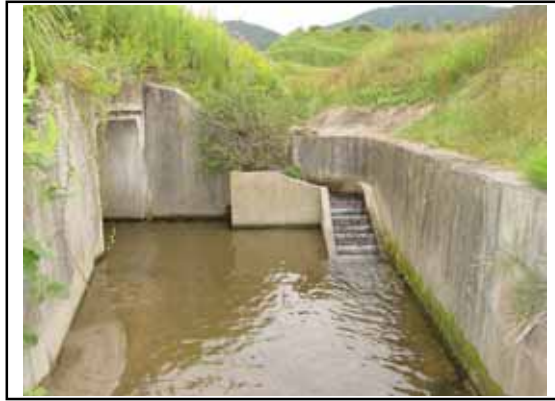
写真-4.5 魚道ブロックの設置例
