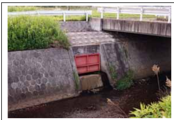
写真-3.1 幹線排水路放流口と河川との落差の例
