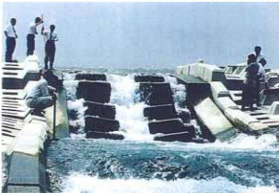
洪水により魚道下部の土砂が吸い出されて魚道が大きく沈下したため、応急的対策として魚道下部にできた空隙約 100m<sup>3</sup> に栗石を充填した。
