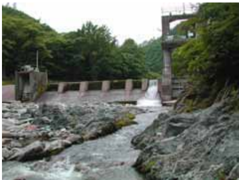
改善前の大川と取水堰
