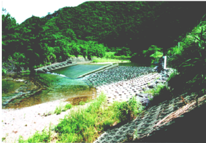
川内川の魚道の設置事例
