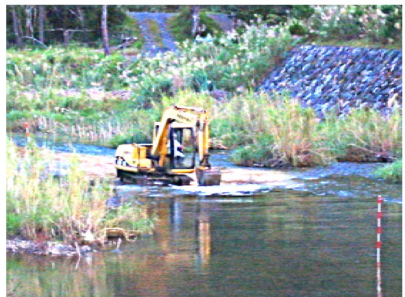
重機による河床耕耘
