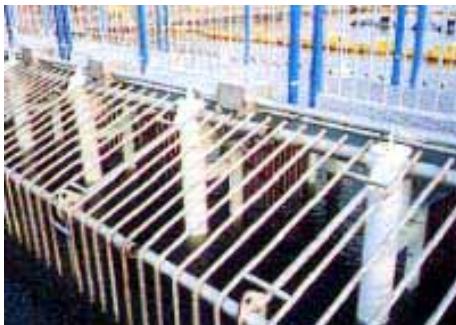
電気スクリーン：電気的なバリアにより魚の侵入を防ぐ装置
