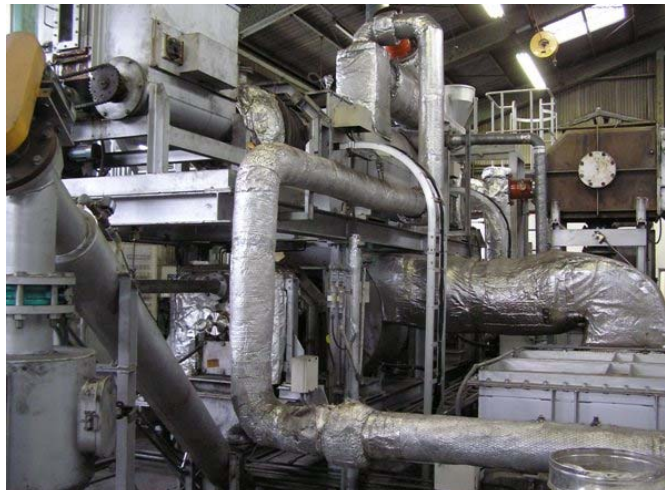
F技術 分解無害化実施状況(小型炉連続試験)
