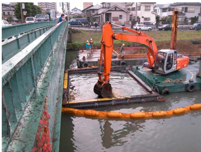
図 6.2.4 覆砂施工状況
