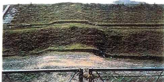
図 3.3 天端及び法面の抜け上がりの例
