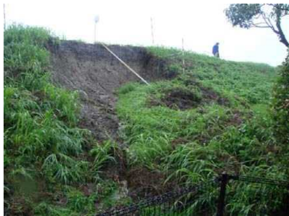
図 2.2 出水後の法崩れの状況
