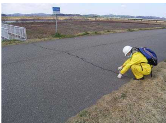
図 3.2 天端舗装のひび割れの例
