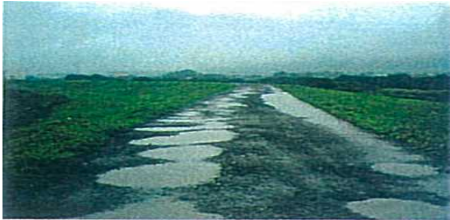
図 2.7 天端に生じた水たまり
