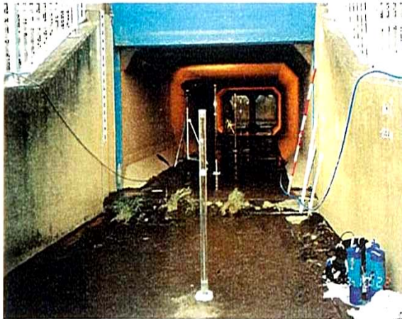
写真-19 アクリル製試験管の立ち上げ
