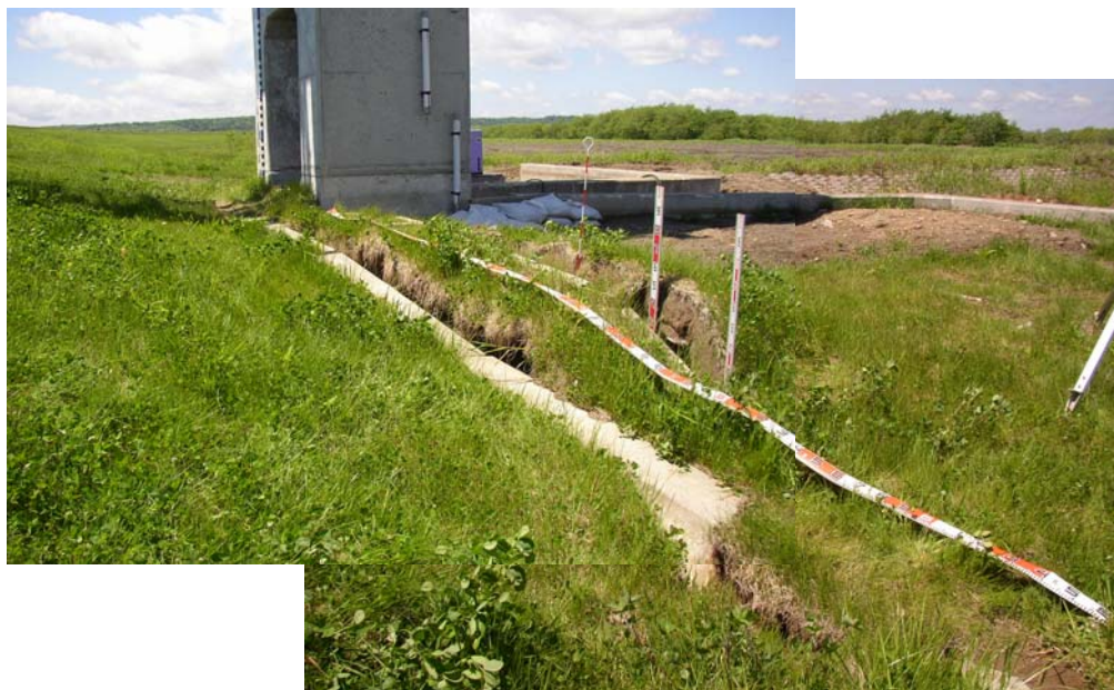
写真-23 堤外のり尻部の変状 亀裂・空洞などの顕著な変状がみられる。
