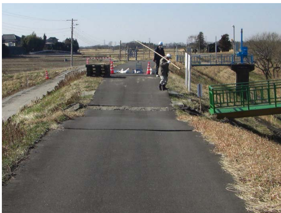
写真-24 天端の沈下と管理橋の落座
