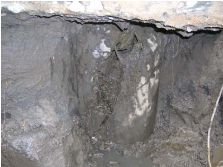
写真-29 基礎杭頭部の破断 吐水槽の荷重により基礎杭頭部が座屈破断している。
