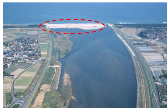
河道閉塞の状況
