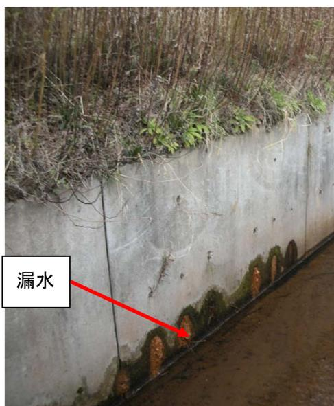
図 2.8 堤脚水路からの漏水
