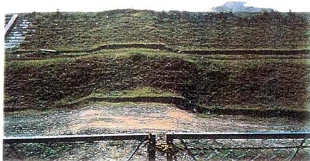
図 2.12 天端及び法面の抜け上がりの例
