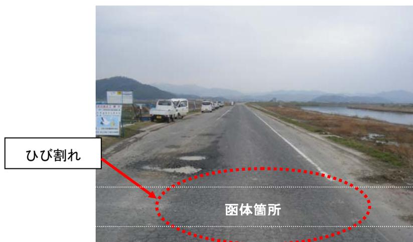
図 2.11 天端舗装のひび割れの例
