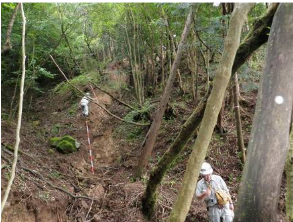
写真3 地すべり頭部から側部に繋がる亀裂
