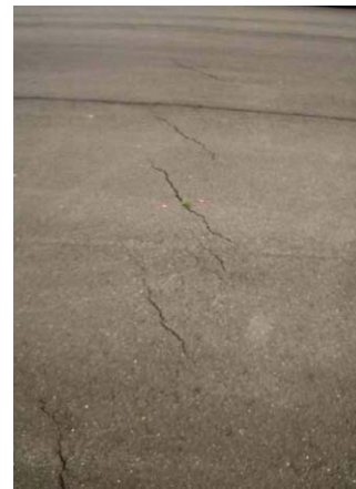
写真4 雁行亀裂
