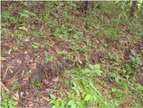
写真1 段差を伴う小規模な開口亀裂
