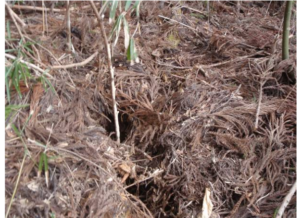
写真2 段差を伴わない開口亀裂
