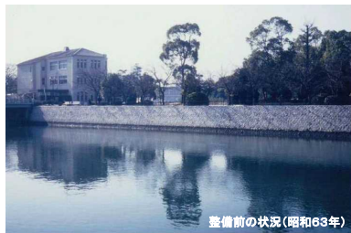
整備前の状況(昭和63年)
