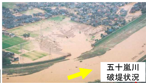
平成16年7月豪雨による浸水状況
