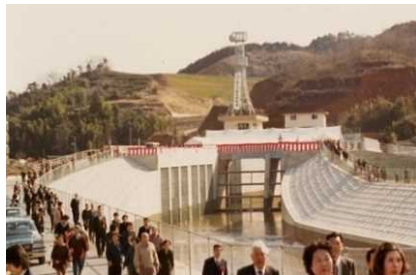
日下川放水路完成 (S57.2)
