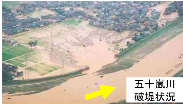
平成16年7月豪雨による浸水状況
