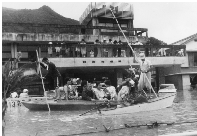
昭和50年8月台風5号の被害状況 (日高村役場前)
