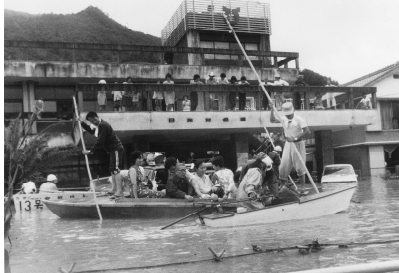
昭和50年8月台風5号の被害状況 (日高村役場前)
