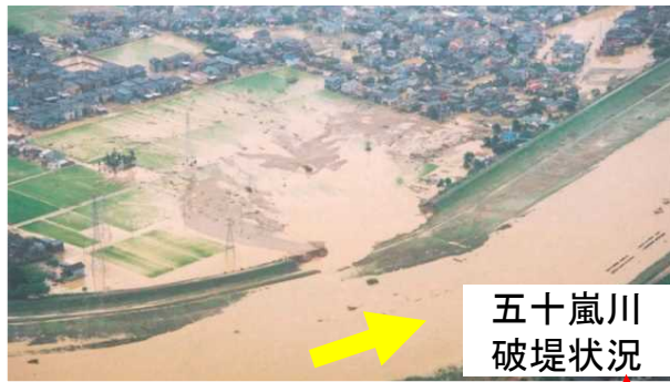
平成16年7月豪雨による浸水状況
