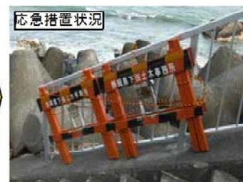
手すりの破損及び応急措置状況
