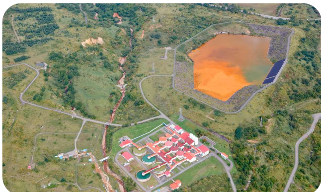
水質浄化施設
