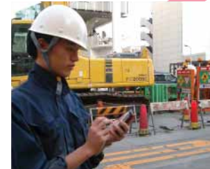
現場からの工事規制状況の入力 Inputting traffic restriction information on work sites
