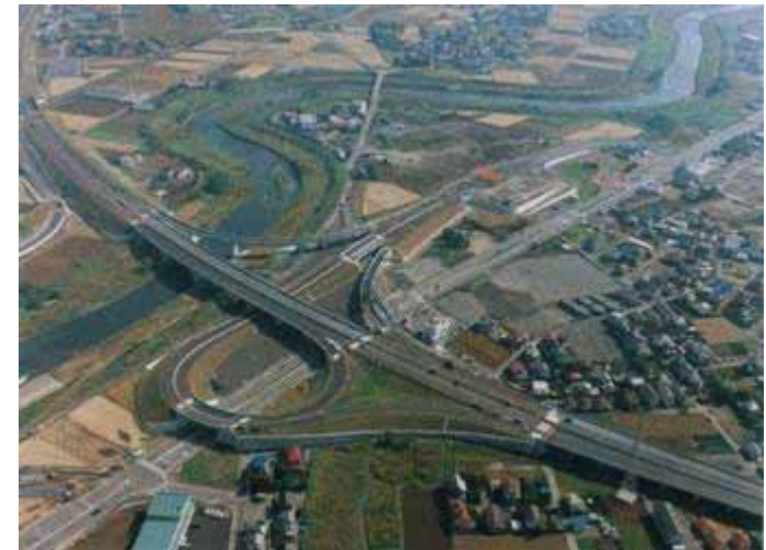
図 既存の高速道路IC (関越自動車道 駒形IC)
