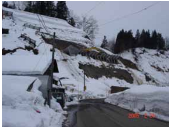
図-1 国道 291 号(県管理)小千谷市浦柄付近積雪期に応急復旧作業中(2005 年 2 月 24 日)
