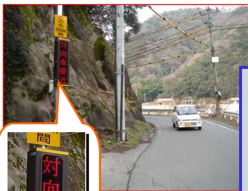
【1.5車線整備に対応した路車協調システムの例】
