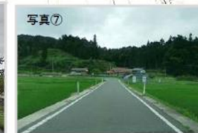
写真⑦ 狭隘区間 曲道区間
