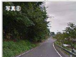
写真⑧ 狭隘区間 植栽繁茂
