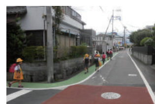
路肩のカラー舗装
