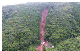
国道3号 14日間通行止め
