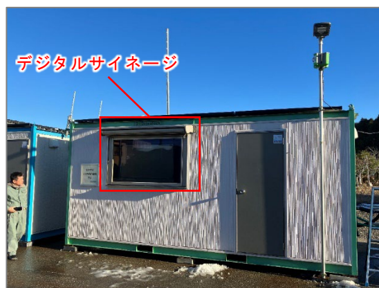
図 30 外壁へデジタルサイネージを 設置したコンテナ
