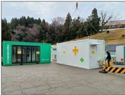
図 49 陰圧設備内蔵型医療用コンテナ (珠洲市立飯田小学校)
