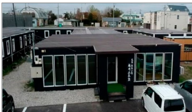
北海道むかわ町学生用仮設住宅
