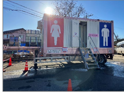
図 43 牽引型のトイレコンテナ (珠洲市立宝立小中学校)
