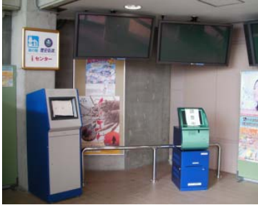
機器が並べられているが全てが調整中
