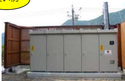
道の駅「美濃にわか茶屋」(岐阜県美濃市) 非常用の電源装置を設置
