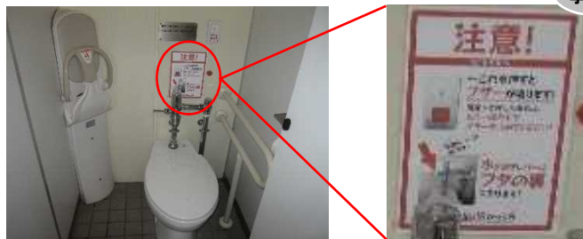
▲施設管理者が独自に設置した利用方法の案内(緊急時レバー)
