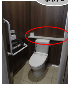
▲手荷物を置くフックと棚の両方を設置した事例
