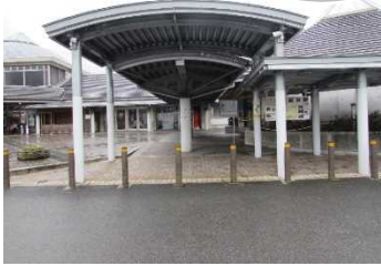
▲駐車場からトイレまで照明を配置していない事例
