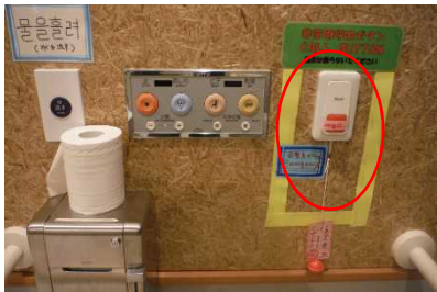
▲非常用ボタンが作動すると外部の回転灯が点滅する事例。ただし連絡を届けるシステムがないため周囲に人がいないとわからないことは課題
