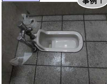
▲便器に汚れが付着している事例
