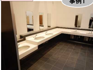
▲清掃を行いやすくするため、洗面台を一連なりに整備した事例
