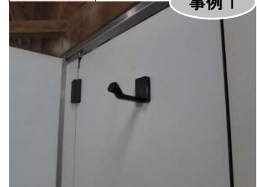
▲手荷物を吊るすフックを設置した事例
