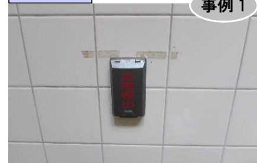
▲緊急時呼び出しボタンの使用方法が剥がれている事例
