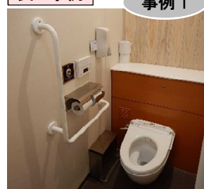
▲手すりを設置した事例
