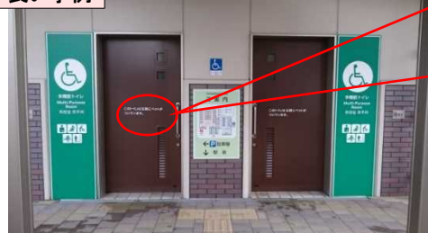
▲多機能トイレを2基設置し、半身麻痺の方に配慮して介助用ベッドを左右対称に配置した事例
