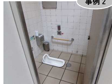
▲手すりを設置した事例(ただし高齢者が立ち上がるためには縦方向の手すりが望ましい)
