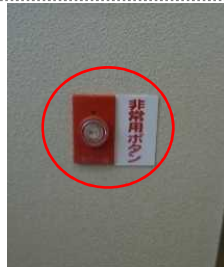
▲各個室、出入り口付近、奥の壁際に緊急時の呼び出しボタンを設置した事例
