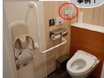
▲便座クリーナーを設置した事例
