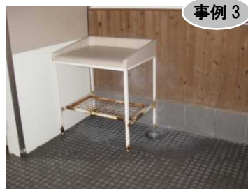
▲おむつ交換台の脚がさびびてしまっている事例
