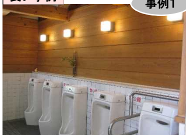
▲改修により照明をLED化し明るくした事例
