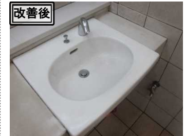
▲手洗い場がくすみ汚れていたため研磨剤等により清掃した事例
