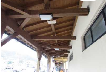
▲駐車場からトイレまで照明を配置した事例
