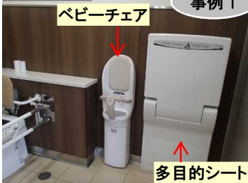
▲多目的トイレと男女の個室に1箇所ベビーチェアと多目的シートを設置した事例
