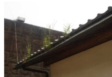
▲雨樋に土埃がたまり雑草が生えた事例
