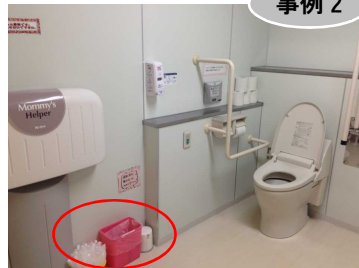
▲紙おむつ処分用のゴミ袋を設置し衛生面に配慮した多機能トイレ整備事例
