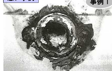
▲尿石により半分以上がふさがれた排水管(「トイレメンテナンスマニュアル」(日本トイレ協会)より)
