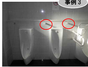
▲フックを設置した事例
