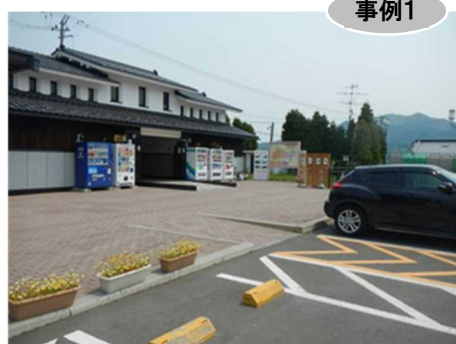
▲トイレまでの動線上に段差がない事例
