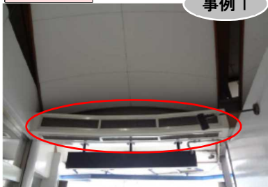
▲エアーカーテンを設置し防虫対策を行っている事例
