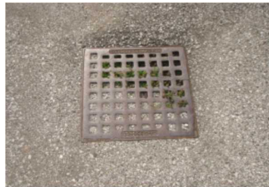
▲雨水排水樹に土砂が溜まり目詰まりしている事例
