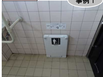
▲フィッティングボードを整備した事例
