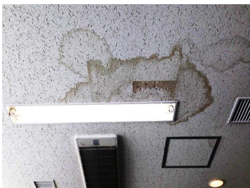
▲天井版の漏水事例
