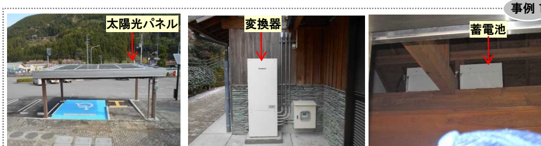
▲災害時に必要な電源を確保した事例(太陽光発電により蓄電)
