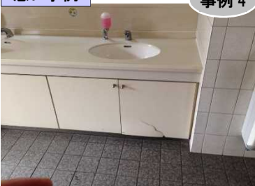
▲破損を放置してしまっている事例
