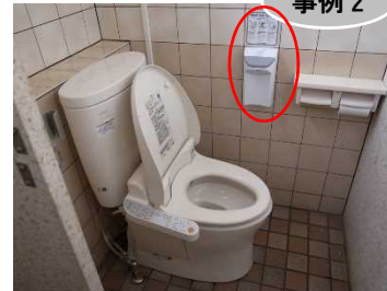
▲便座クリーナーを設置した事例
