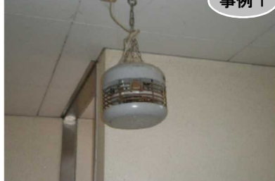
▲殺虫灯を設置したが汚れて蜘蛛の巣に覆われている事例
