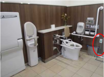
▲転倒時でも使いやすい位置に緊急時の呼び出しボタンを設置した事例
