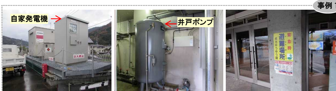
▲非常用電源、ポンプを設置し、災害時に利用可能であることを示した事例
