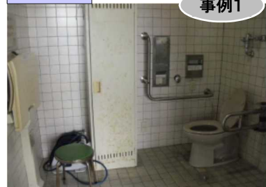
▲清掃用具の保管場所がなく、多機能トイレ内にロッカーを設置する等、本来の機能が損なわれた事例
