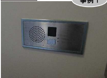
▲擬音装置を設置した事例
