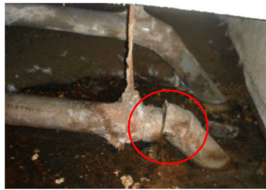
▲地盤沈下により排水管接続部が破損した事例
