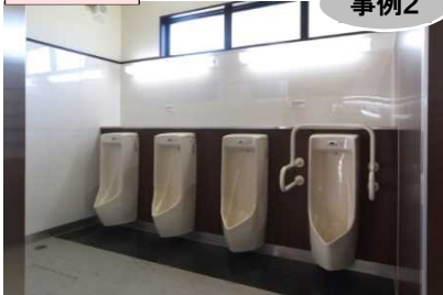
▲清掃を行いやすくするため、床置きではなく、壁掛けの小便器を整備した事例
