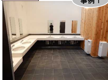
▲車いす利用者でも利用可能な高さ にハンドドライヤーを設置した事例
