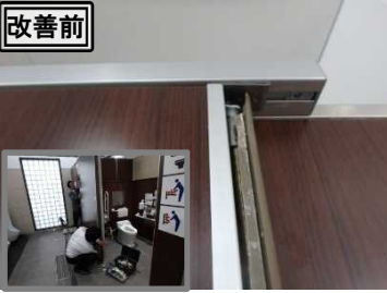
▲引き戸の不具合を補修した事例
