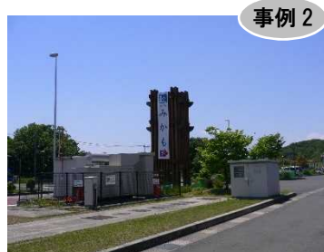
▲非常用電源整備事例
