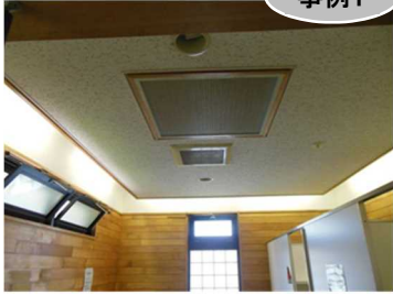
▲換気扇と換気が行える窓を配置した事例
