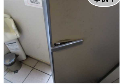
▲鍵が破損している事例
