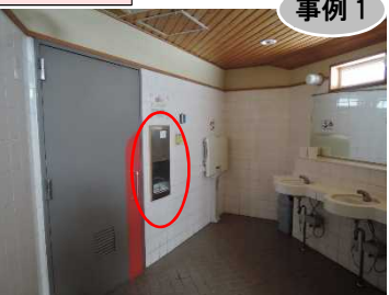
▲破損防止のためはめ込み式としたハンドドライヤーの事例
