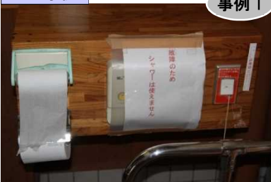
▲故障を放置してしまっている事例
