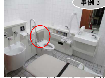
▲便座背後に背あてを設置し高齢者・身体障害者に配慮した多機能トイレ整備事例
