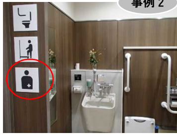
▲男女の個室に1箇所オストメイト対応器具を設置しピクトグラムで表示した事例
