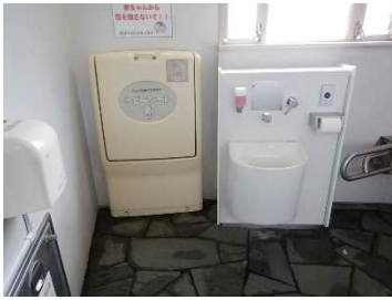
▲オストメイトが設置されているが、ピクトグラム表示がされていない事例
