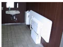
▲多機能トイレを2基設置し、半身麻痺の方に配慮して介助用ベッドを左右対称に配置した事例
