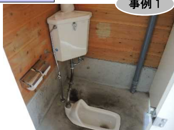
▲個室に十分な空間が確保されていない事例
