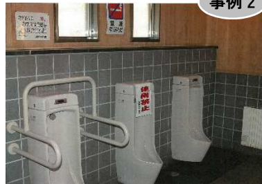
▲故障を放置してしまっている事例
