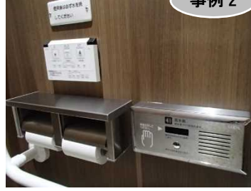
▲擬音装置を設置した事例
