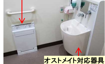
▲オストメイト対応器具・フィッティングボード設置事例
