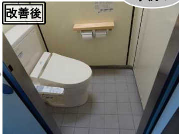
▲個室が日中でも暗かったため便器の洋式化に合わせて感知式のLED照明を設置した事例
