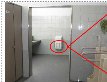
▲破損防止のため防護柵を設置したハンドドライヤーの事例
