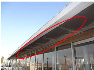
▲雨水が軒裏に漏水した事例
