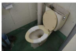
便座をガムテープで補修
