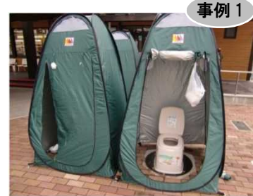
▲災害用トイレ整備事例
