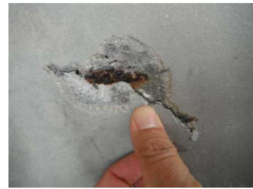
▲鉄筋コンクリートに亀裂が発生し、爆裂や鉄筋の腐食が進行している事例
