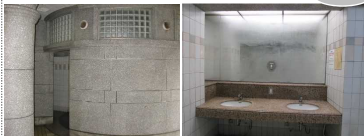
▲冷暖房がなく入り口にドアもないため夏季や冬期の利用では快適性が劣り、天候によっては鏡が結露して見えなくなっている事例
