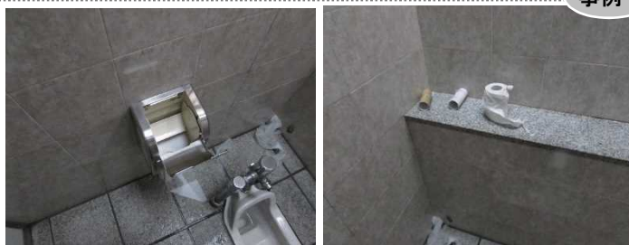
▲予備も含めてトイレットペーパーが清潔な状態ではない事例
