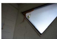
窓が割れている
