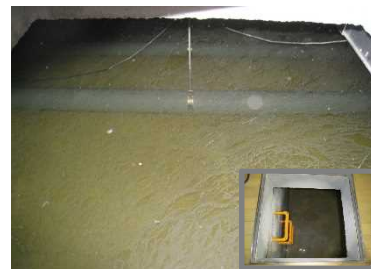
▲床下ピット内の滞水事例
