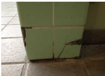
▲タイルの損傷事例
