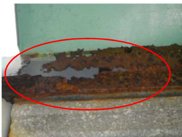
▲屋外の鉄部が腐食し欠損が進行している事例
