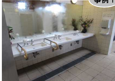
▲鏡が結露し見えにくくなっている事例
