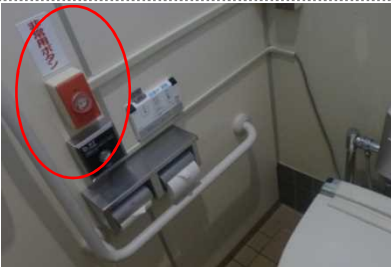
▲各個室、出入り口付近、奥の壁際に緊急時の呼び出しボタンを設置した事例
