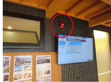
▲非常用ボタンが作動すると外部の回転灯が点滅する事例。ただし連絡を届けるシステムがないため周囲に人がいないとわからないことは課題
