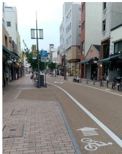
無電柱化と合わせた通行空間の整備例（愛媛県松山市）
