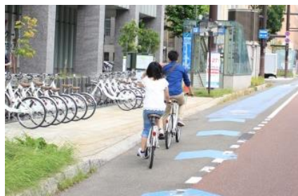
サイクルポート近くの自転車通行空間の整備事例(北海道札幌市)
