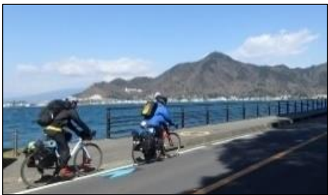
路面表示(矢羽根)の設置
