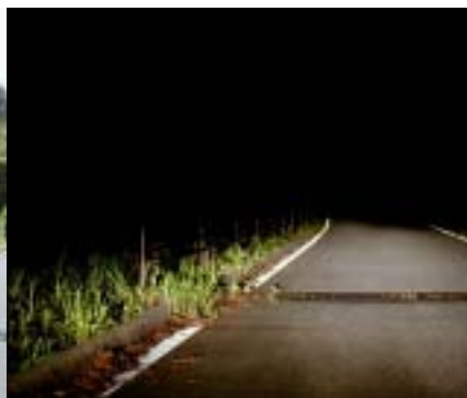
視線誘導施設なし
