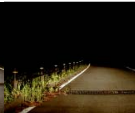
視線誘導施設あり(2cm厚の反射テープ設置)
