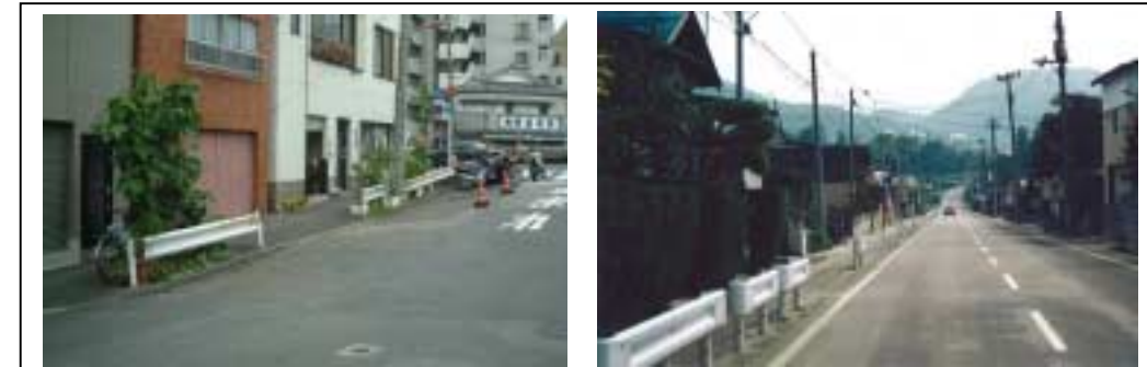
歩車道分離のために車両用防護柵が設置されたと考えられる例 車両の路外逸脱防止・進行方向復元といった車両用防護柵としての機能は求められていない。縁石等、他の施設でも代替は可能である
