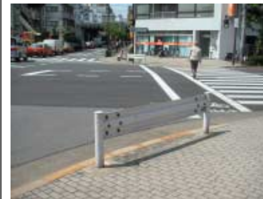
交差点部に歩行者の 巻き込み防止 のために防護柵が設置された例 縁石や駒止め等 、他の施設でも代替は可能であり、防護柵は必ずしも必要ない
