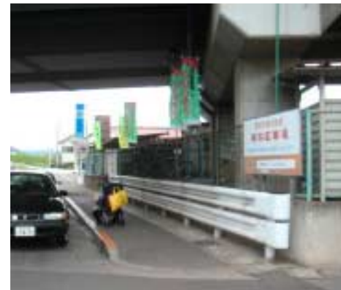
鉄道高架橋の橋脚保護のために防護柵が設置されたと考えられる例 橋脚は、防護柵の柵高と同程度の一段高い構造物上にあるため防護柵は必ずしも必要ない
