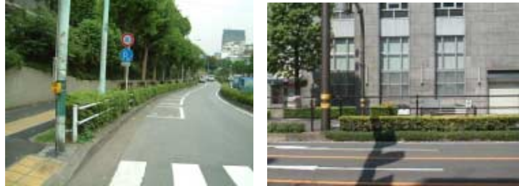
植栽帯と横断防止柵を併用した例 植栽帯により歩行者の横断防止機能が確保されているため、防護柵は必ずしも必要ない
