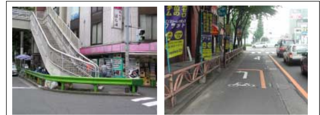
色彩の彩度が高く、周辺景観から浮立った印象となっている防護柵の例
