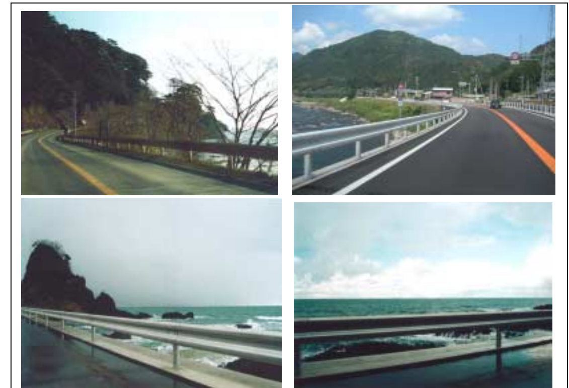
外部への眺望を阻害している透過性の低い防護柵の例
