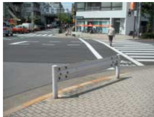
交差点部に歩行者の横断防止のために防護柵が設置された例 他の施設でも代替は可能であり、防護柵は必ずしも必要ない
