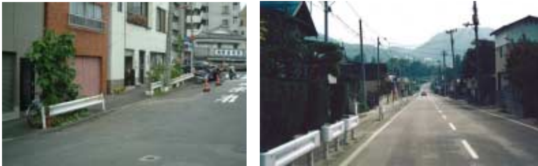
車両用防護柵が断続的に設置された例 車両の路外逸脱防止・進行方向復元といった車両用防護柵としての機能が果たされていない
