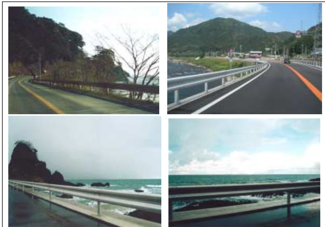
外部への眺望を阻害している透過性の低い防護柵の例
