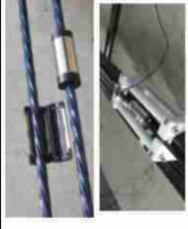
センサーを利用した橋梁ケーブル張力のモニタリング
