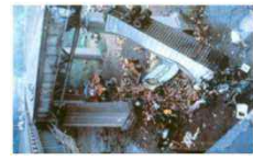
マイアス橋の崩壊（1983年）
