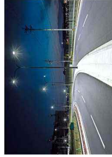
LED照明による省エネ効果 消費電力約6割削減 (高圧ナトリウム灯比) 出典：令和3年度 道路分科会 基本戦略部会資料
