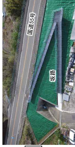
想定した浸水深よりも高い歩道部への坂路を整備 (国道55号 高知県安芸郡奈半利町)
