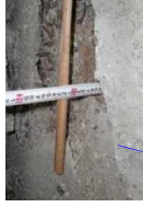
構造目地の腐食・漏水 中床版上面のコンクリートはく離
