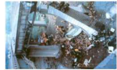
マイアス橋の崩壊 (1983年)
