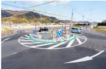
図-3 仮設ラウンドアバウト
