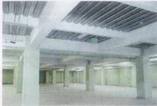
写真 3—6 石綿含有耐火被覆板の使用例
