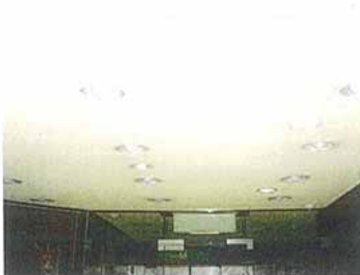
写真 3-3 天井・壁の例
