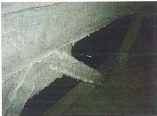
写真 3-1 鉄骨部分の例
