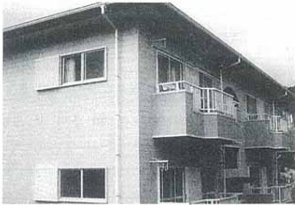
写真 3—10 外装材の使用例
