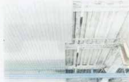
写真 3—8 屋根用折版裏断熱材の使用例
