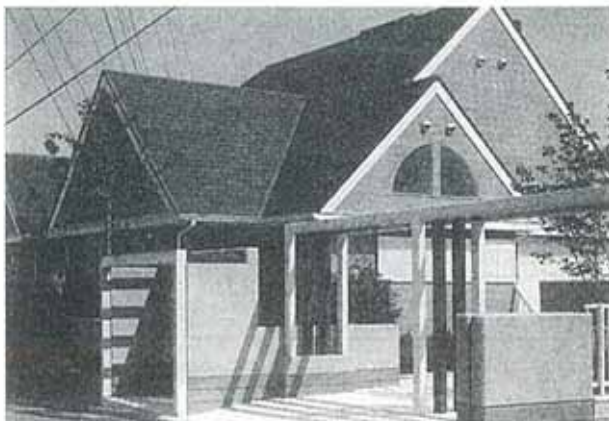
写真 3—11 屋根材の使用例
