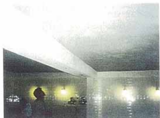
写真 3-4 浴室天井の例
