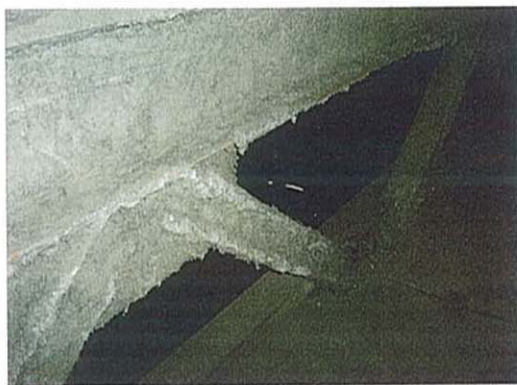
写真 3-1 鉄骨部分の例
