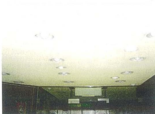
写真 3-3 天井・壁の例
