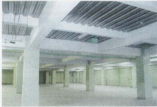
写真 3—6 石綿含有耐火被覆板の使用例
