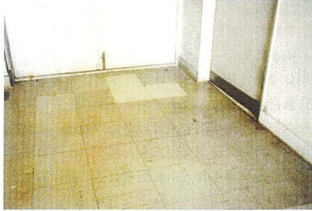
写真 3—9 内装材の使用例
