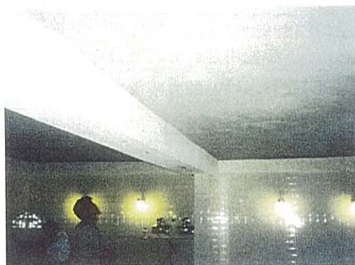
写真 3-4 浴室天井の例
