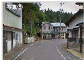
カーブ連続区間 見通しの悪い区間
