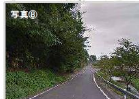
狭隘区間 植栽繁茂
