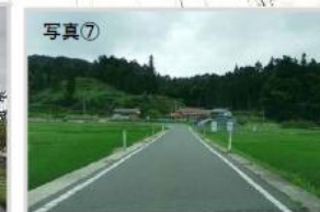
狭隘区間 単調区間
