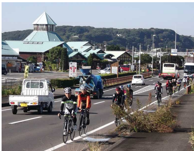
(千葉県 国道127号) 鉄道駅と道の駅を結ぶルートに矢羽根型路面表示を設置し、通行環境の安全を確保
