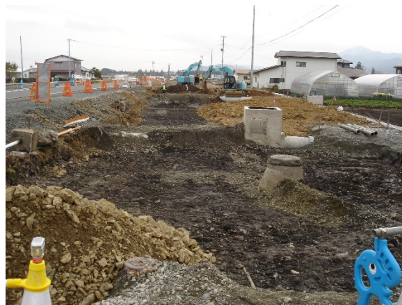
拡幅により路床・路盤構築 等
