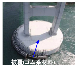
主塔基礎天端のコンクリート被覆
