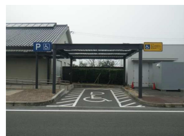
身障者駐車場屋根の設置 (室津PA上り)
