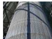
10年後調査結果 (明石海峡大橋) ケーブルに腐食はみられず、システムが確実に防食していることを確認 [参考]
