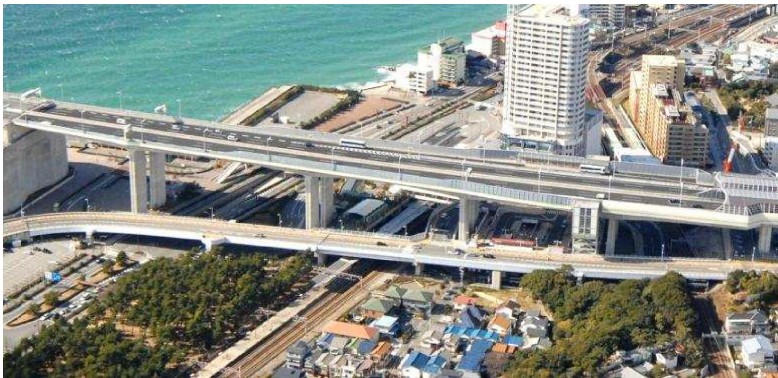
舞子高架橋の剥落対策
