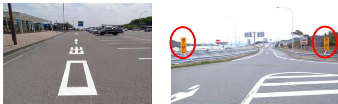
SAにおける逆走対策実施例
