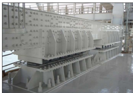
大鳴門橋2P変位制限
