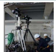
疲労亀裂の遠隔調査状況
