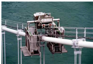
ケーブル作業車での近接
