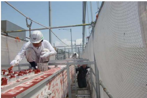
瀬戸大橋補剛桁の塗替塗装
