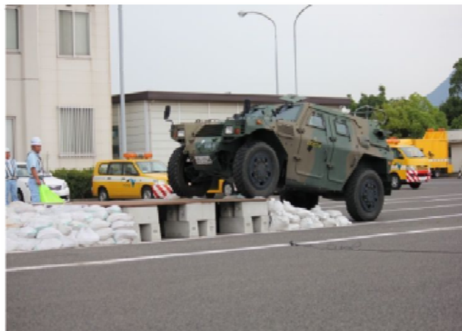
段差補修訓練状況 土のうによる段差修正
