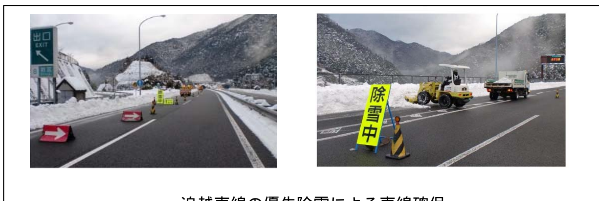
追越車線の優先除雪による車線確保
