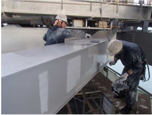
瀬戸大橋補剛桁の塗替塗装
